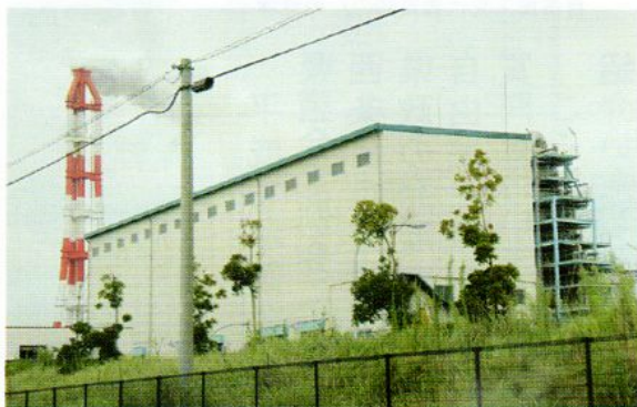
掘削土砂の焼却処分を行う鹿島共同再資源化センター
