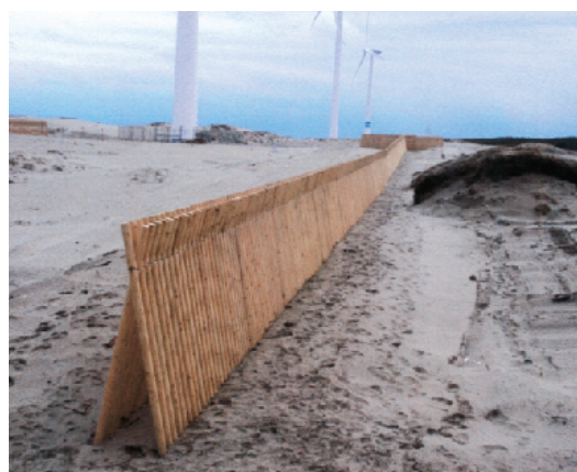
砂防柵の設置
